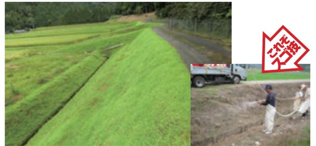
すでに雑草が繁茂している法面(水田畦畔)にセンチビードグラスの種子を吹付播種し、芝生化させることで除草作業を軽減化する雑草抑制法を確立。従来の吹付施工では既に雑草が繁茂する法面において種子の定着が困難であったが、今治産タオルの端材を再利用した製紙原料を用いる特殊な活着材を使用することで定着率の悪さを克服。
