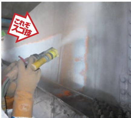
塗装業界で注目を浴びる新工法「ダブルプラスト工法」は、有害物質を含む既存塗膜を完全に除去したのち、素地調整程度1種を成形する工法。ウェットプラストで湿潤させた後に有害物質を1回で完全に除去し、オープンプラストで湿式によるプラストを実施した際に発生する戻り錆を除去する。
