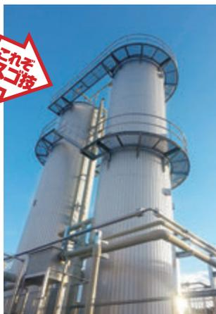
嫌気性微生物を使用した排水処理装置「SUPER Depcer」は、従来処理が困難だった高濃度排水を省エネルギー・省コスト・省スペースで可能にする。処理過程で得られるメタンガスが自家発電の燃料として利用できることなどから燃料コストが削減でき、従来の排水処理法よりも余剰污泥が大幅に減量、機器動力も約1/10程度となっている。
