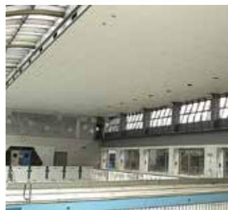
温水プール天井の施工事例
