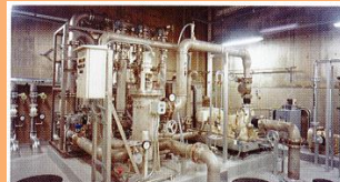
中水道システム (膜分離方式) Intermediate water supply system (membrane separation process)
