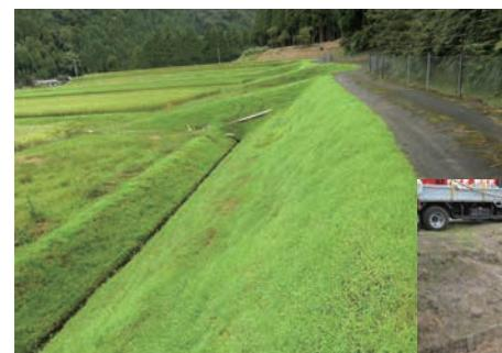
すでに雑草が繁茂している法面(水田畦畔)にセンチピードグラスの種子を吹付播種し、芝生化させることで除草作業を軽減化する雑草抑制法を確立。従来の吹付施工では既に雑草が繁茂する法面において種子の定着が困難であったが、今治産タオルの端材を再利用した製紙原料を用いる特殊な活着材を使用することで定着率の悪さを克服。
