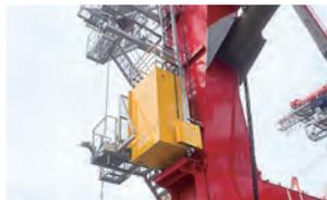
港湾のクレーン設備に設置するエレベーターは、台風や激しい雨風にさらされるため、より高い安全性が求められる。ラック&ピニオン方式と軽量ラックレールを採用したコンテナクレーン用エレベーターは、堅牢な耐久性を実現。地上60m規模の施工実績を有する。
