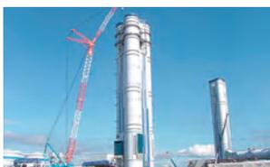
高効率石炭炊き発電プラント向煙突2基を製作。構造体である外筒と、燃焼排ガスが通る筒内ダクト(内筒)をそれぞれ製作し、外筒に内筒を挿入した上で出荷。外筒はφ7400・10000、内筒は共にφ6800、高さ150m。内筒の材質は長期メンテナンスフリーを可能とするNSSC270材。
