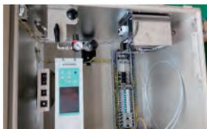
屋外環境下や周囲環境の悪い場所での制御盤にはクーラーの導入が進んでおり、空調負荷軽減のため断熱材が求められている。仮に10mmのバリシールドを制御盤内に張ると、空調負荷を約50%軽減できる。盤内のスパークや発熱による発火があった場合も延焼遅延効果を発揮。
