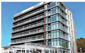
鉄骨造と鉄筋コンクリート造のハイブリッド工法であるSRC造で建築した病院の鉄骨を担当。鉄骨の耐震性と、鉄筋コンクリートの耐火性をミックスした高性能な建築。SRC工法に対応できる鉄骨製造・加工メーカーは数少なく、同社は大手ゼネコからの信頼も厚い。
