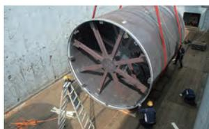
セメントの製造時などに使用されるロータリーキルンの円筒部分の製作は、外周公差+9mm、内半径公差+1.5mm、内直径公差+3mmと非常に厳しい要求に対応する必要がある。精度を保つため、製作中の確認や検査など寸法管理が重要で、ノウハウが求められる。
