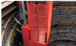
工事用エレベーター「モグラック」は、狭い現場でも取り付け可能な省スペース設計が特長。地下100m規模の納入実績があり、山間部での下水道工事や地下鉄工事などに採用されている。現場の安全性を確保するとともに、作業の効率化を実現。作業者の負担を大幅に軽減できる。
